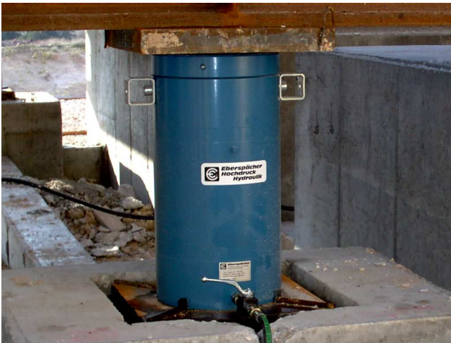
Hydro-Stellring-Zylinder Für die Schalung
