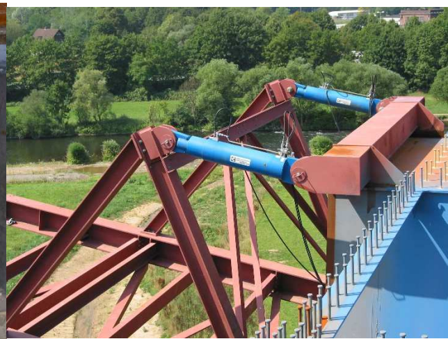
Schnabel-Hub-Vorrichtung An den Vorbauschnabel angeschraubte hydraulische Hubelemente
