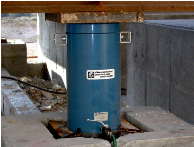
Hydro-Stellring-Zylinder Für die Schalung
